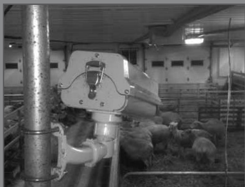
Installation au plafond : éviter le centre des parcs pour diminuer les risques d'accrochages au moment de l'écurage.
