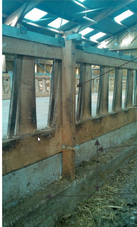
Poteau Bois avec ferrures boulonné entre 2 panneaux de cornadis pour permettre de fixer les claies
